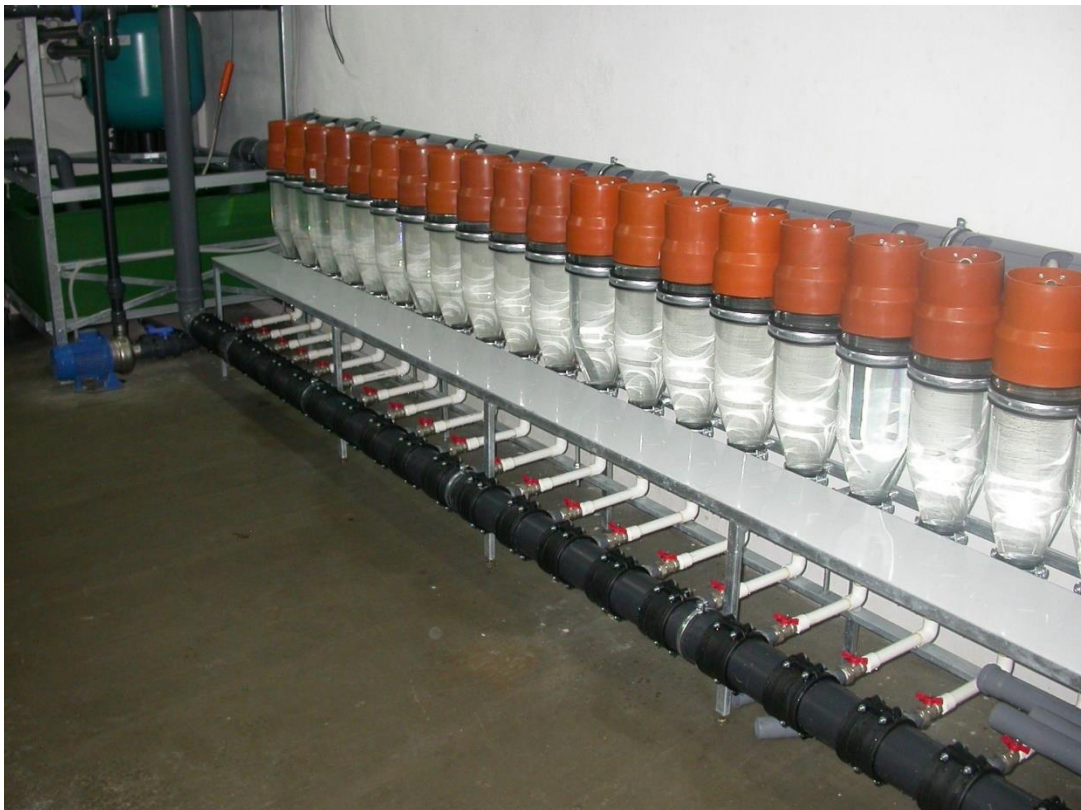
Fot. 3. Układ wylęgarni z podestem ułatwiającym prace pielęgnacyjne.
