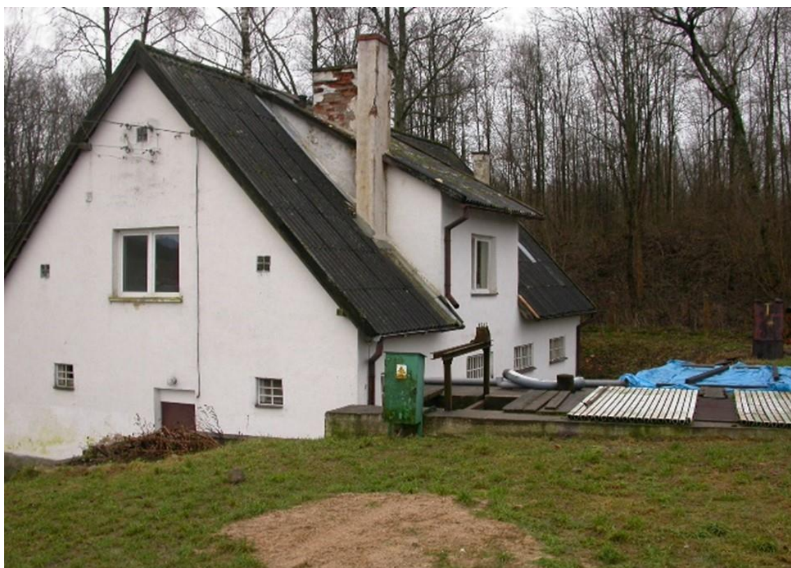
Fot. 1. Wylęgarnia koregonidów w Doliwach: widok na budynek od strony ujęcia wody. (z lewej) i halę inkubacyjną (z prawej) (fot. M. Szczepkowski).
