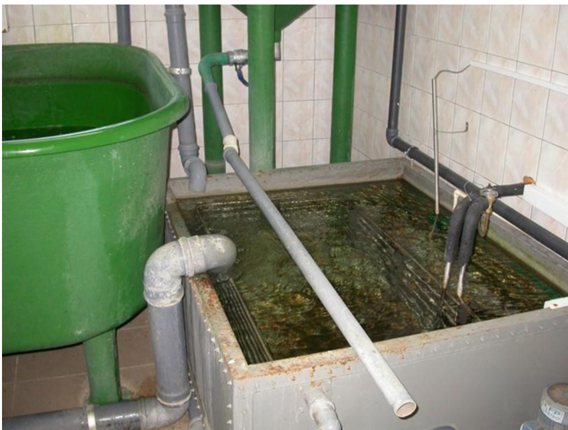
Fot. 4. Wymiennik ciepła z układu schładzania wody umieszczony w dolnym zbiorniku retencyjnym (z lewej) oraz biofiltr z zaworem wielodrożnym (z prawej) stosowane w wylęgarni koregonidów (fot. M. Szczepkowski).
