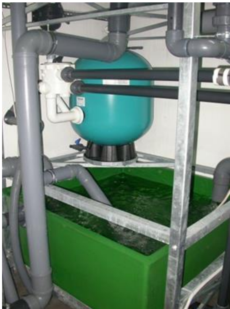
Fot. 5. Wymiennik ciepła z układu schładzania wody umieszczony w dolnym zbiorniku retencyjnym (z lewej) oraz biofiltr z zaworem wielodrożnym (z prawej) stosowane w wylęgarni koregonidów (fot. M. Szczepkowski).
