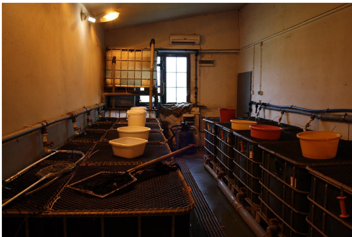
Fot. 3. Recyrkulacyjny system akwakulturowy przystosowany do rozrodu suma (fot. S. Krejszeff).
