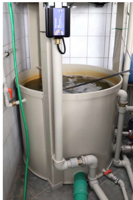
Fot. 6. Przykład zbiorników retencyjnych wykonanych z polietylenu (Zakład Hodowli Ryb Jesiotrowatych, Instytut Rybnictwa Śródlądowego).
