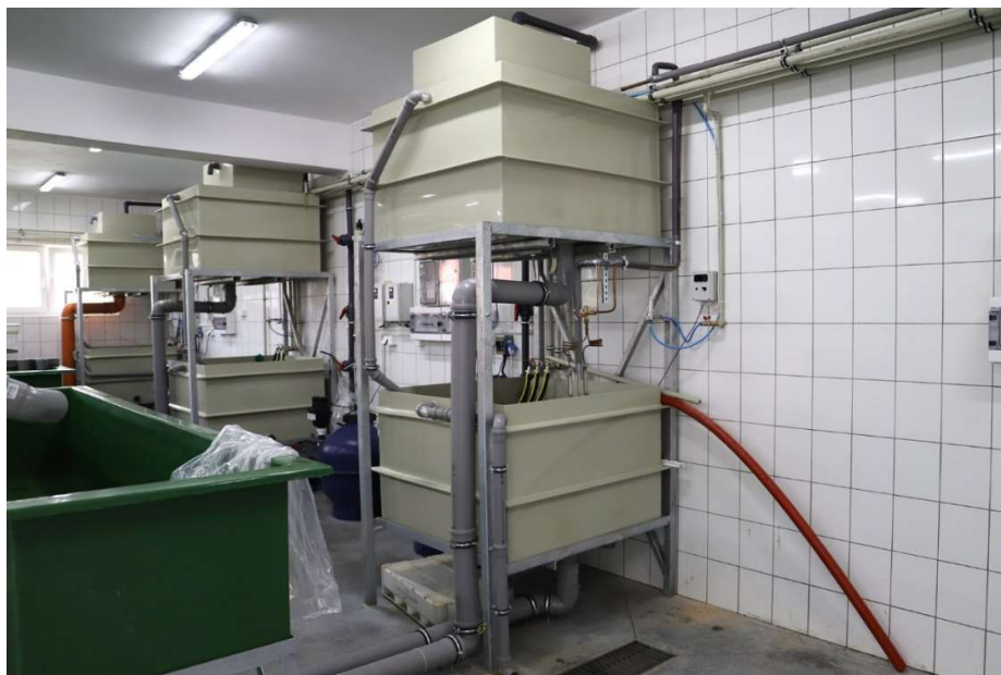
Fot. 2. Górny i dolny zbiornik retencyjny recyrkulacyjnego systemu akwakulturowego do inkubacji ikry i podnoszenia wylęgu szczupaka (Zakład Rybacki Janowo, Okręg Mazowiecki PZW w Warszawie).
