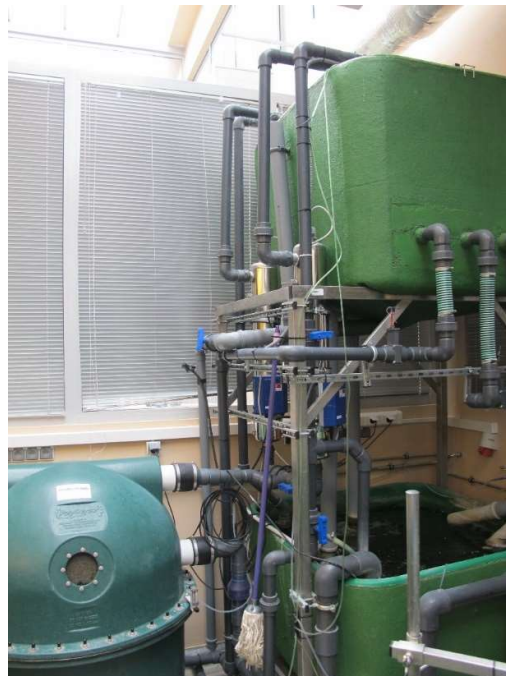
Fot. 5. Przykład zbiorników retencyjnych wykonanych z laminatu poliestrowo-szklanego (Centrum Akwakultury, UWM w Olsztynie).
