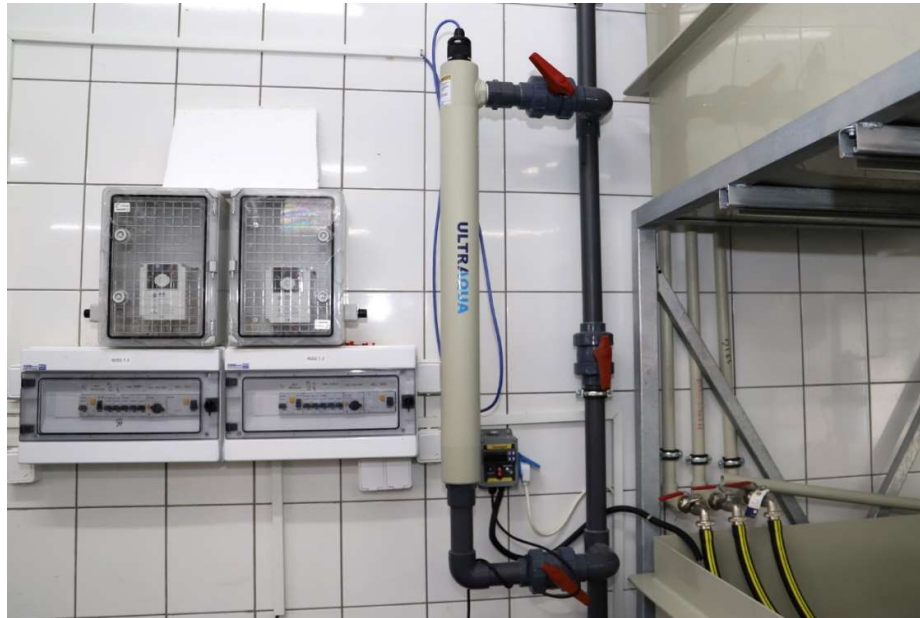
Fot. 15. Lampa UV recykulacyjnego systemu akwakulturowego do inkubacji ikry i podnoszenia wylęgu szczupaka zainstalowana w dolnym zbiorniku retencyjnym (Zakład Rybacki Janowo, Okręg Mazowiecki PZW w Warszawie).
