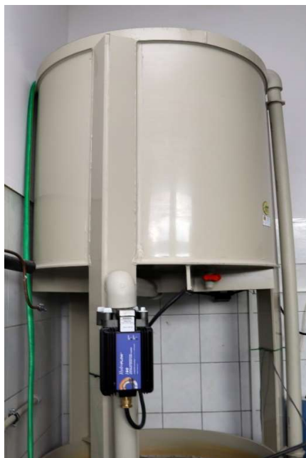
Fot. 6. Przykład zbiorników retencyjnych wykonanych z polietylenu (Zakład Hodowli Ryb Jesiotrowatych, Instytut Rybnictwa Śródlądowego).
